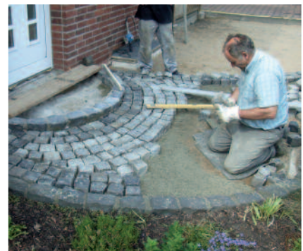
Verlegen von Kleinpflaster in PCI Pavifix DM.
