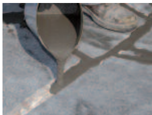
Pavifix CEM mit einem geeigneten Gießgefäß in die vorbereiteten Fugen einbringen.
