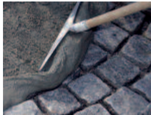
Beim Schlammverfahren lässt sich PCI Pavifix CEM mit einem Gummischieber leicht in die Fugen einbringen.
