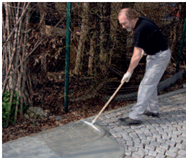
Beim Schlämmverfahren lässt sich PCI Pavifix CEM leicht mit einem Gummischieber in die Fugen einbringen.
