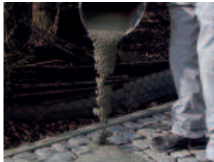
Aufbringen von PCI Pavifix CEM auf die zu verfugende Fläche.
