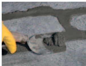
Überstand mit einer Spachtel abstechen.
