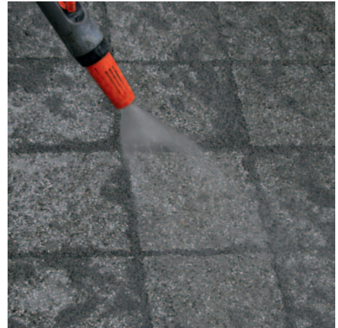
Bei Fugen von 3 - 8 mm das Einbringen in die Fugen mit dem Wasserstrahl unterstützen. Bei besonders schmalen Fugen den Wasserstrahl entlang den Fugen führen. Nachgesackte Fugen sofort mit frischem Material auffüllen.
