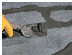
Nach Anziehen des Mörtels (Fingerkuppentest) Überstand mit einer Spachtel abstechen.
