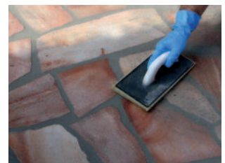
Anschließend Plattenbelag mit einem Schwammbrett nachwaschen.
