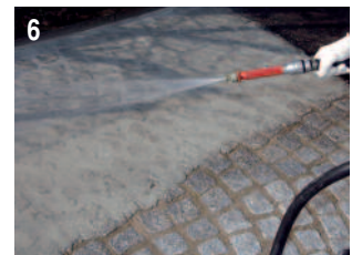
6 Anschließend erfolgt das Abreinigen mit dem Wasserschlauch. Um beim Reinigen der Pflastersteine ein Ausspülen der Fugen zu vermeiden, ist der Wasserstrahl nahezu horizontal zur Oberfläche zu halten.
