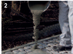
2 Aufbringen von PCI Pavifix CEM Rapid auf die zu verfugende Fläche.
