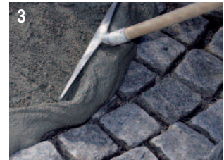
3 PCI Pavifix CEM Rapid mit einem Gummischieber in die Fugen einarbeiten.
