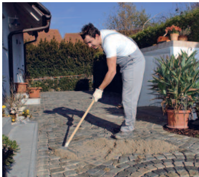
Der 2-komponentige Pflasterfugenmörtel PCI Pavifix PU ist wasserdurchlässig und verhindert somit eine vollständige Versiegelung der Flächen. Regenwasser kann schnell in den Untergrund abfließen.
