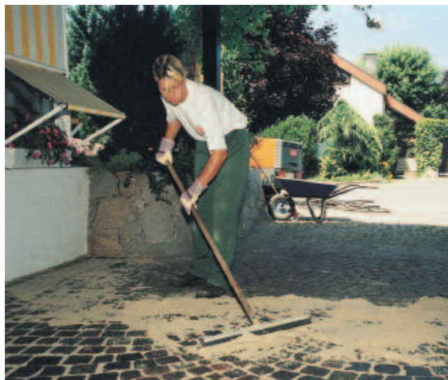
PCI Pavifix 1K lässt sich mit einem Gummischieber leicht einbringen und verdichten und ergibt ein gleichmäßiges Fugenbild.
