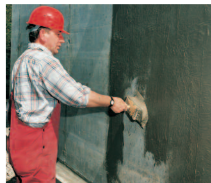
PCI Barraseal ist plastisch-geschmeidig. Poren und Vertiefungen werden leicht und schnell geschlossen.
